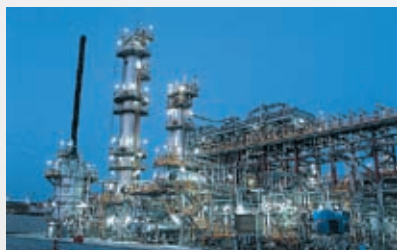
Μονάδα Υπεραποθείωσης Νιτζελ
