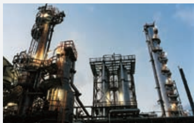
Μονάδα Βαθιάς Αποθείωσης Νιτζελ
